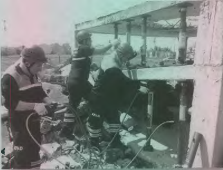
Resim 21: binada çökmeyi engellemek için yürütülen destekleme çalışması
