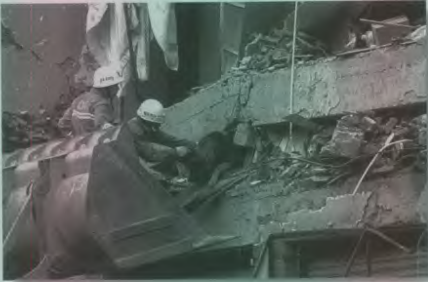
Resim 18: Katmanlar hâlinde çökmüş bir binada kurtarma çalışması
